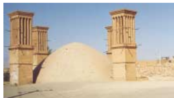
Zisterne im Zentrum von Yazd.
