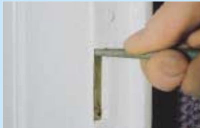
So wird der Durchlass des Schlosses vergrössert.
